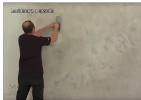
Étape 6 - Pour obtenir une plus grande lucidité, vous pouvez toujours passer notre spatule pour un polissage à sec. Si désiré, donner une protection avec Savon d'Eau, Cera del Vecchio, Vetro Lucido ou Opaco, en fonction de la respirabilité ou de la résistance requise.
