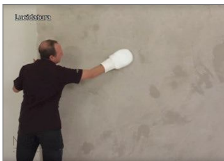
Étape 5 - Lorsque le produit s'éclaircit en montrant qu'il est presque sec, polir la surface avec un gant PE6.
