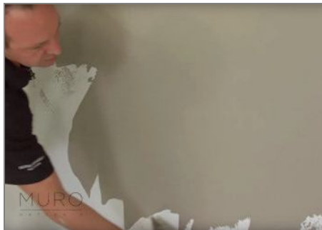
Étape 3 - Appliqué en une seule couche, répartir librement le produit avec la truelle.
