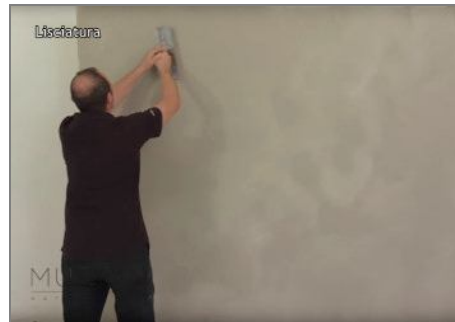
Étape 4 - Lorsque le produit commence à sécher (15/20 minutes) lisse avec notre spatule, à l'aide de l'eau pulvérisée.
