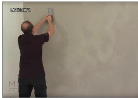
Schritt 4 - Wenn das Produkt fängt zu trocknen an (15/20 Minuten), glätten Sie es mit unserem Spatel, mit der Hilfe von aufgespritztem Wasser.
