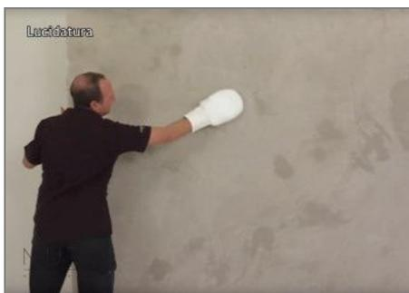
Schritt 5 - Wenn das Produkt klärer wird und zeigt, dass es fast trocken ist, polieren Sie die Oberfläche mit einem PE6-Handschuh.
