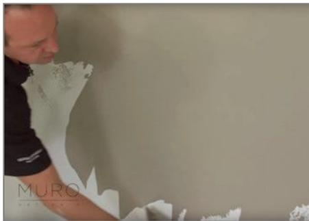
Schritt 3 - Tragen Sie das Produkt in einer Schicht auf. Verteilen Sie es mit der Kelle.
